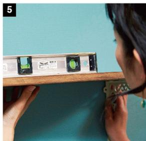
5 あれば水平器で水平を確認しながら、棚受けをビスで壁の下地に留める。
