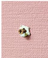
1: ボードアンカー(写真の白い部分)を先に電動ドライバーでしっかり奥まで固定する。
