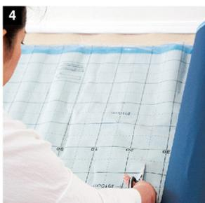
4 貼りたい壁の縦の長さを測り、プラス10センチ分の長さに壁紙を切る。
