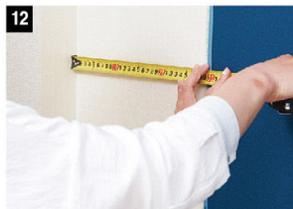
12 壁の端近くまできたら、残りの壁の幅を測り、その幅に、重ねる側の2cmと最後に切り落とす余分5cmの幅を足して壁紙をカットし、最後の1枚を貼りやすい大きさにする。
