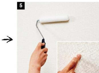
ローラーにのりをつけて壁に塗る。ローラーにダマがつかないように注意。のりの量は、指で壁をこすってみて跡がつくくらいを目安に。
