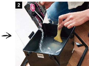
バケツにぬるま湯を入れ、壁紙用のりを少しずつ入れながらダマが出来ないように混ぜて溶かし、あんかけくらいの固さになるように調整する。
