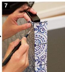
7 角の部分は、角に向かって端からカッターで切り込みを入れてカットする。巻き込む部分は余分を見てカットする。
