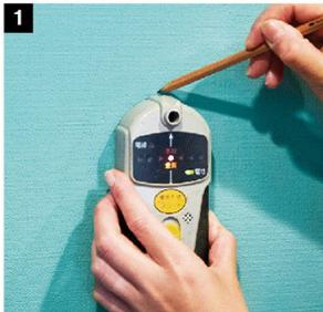
1 棚を取り付けたい壁の下地を探し、壁に印をつける。針で刺すタイプの下地探しとセンサータイプの下地探しを併用すると尚良い。
