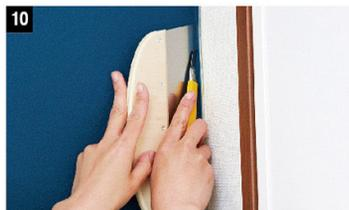
10 地べらで角を押さえながらカッターで余分を切り落とす。このとき切り落とす壁紙側にカッターが来るようにすると、地べらの厚み分外側で切れる。
