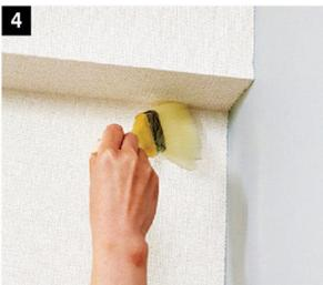
壁の端から壁1枚分の幅にのりをつける。壁の端はのりハケを使用してしっかりとつける。
